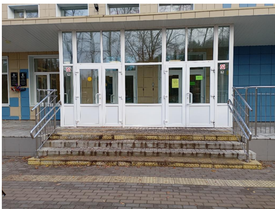
Фото № 4 Дверь (входная)
